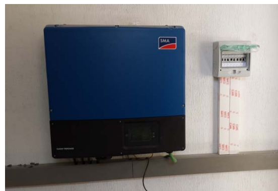
Inversor de red de 20 kW
